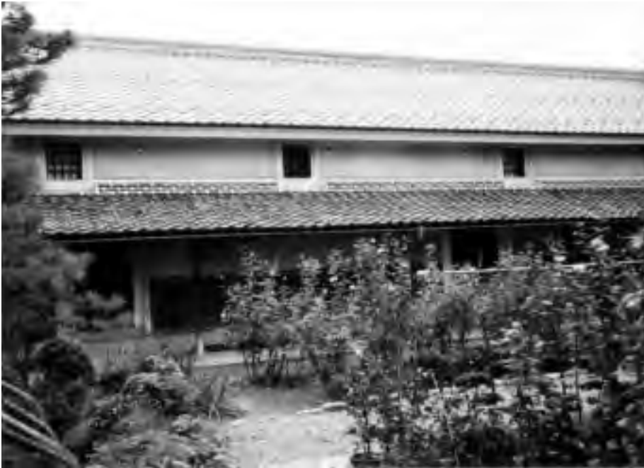
写真1 穀蔵（右側入口）と二間蔵（左側入口）
