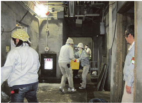
図画30 地下通路でのコンテナ運びだし
