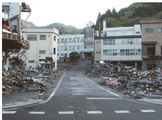
図画5 2011年5月8日釜石市役所第1庁舎
